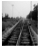
D. 铁轨铺在枕木上
